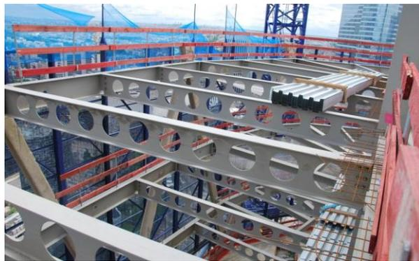
Figure 4-4 : Structure métallique de la Tour D2 (Construir Acier)
